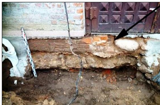
Ryc. 8. Mielżyn, gm. Witkowo – remont fundamentów kościoła p.w. Wszystkich Świętych. Wapienna ława fundamentowa fasady; wyżej zaznaczony strzałką relikwiant lewego węgara pierwotnego wejścia do kościoła (fot. P. Wawrzyniak).
