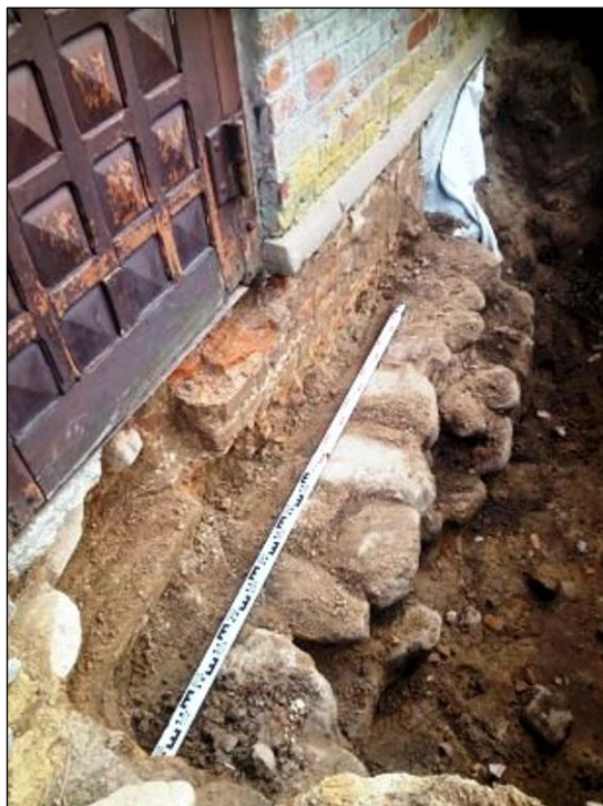
Ryc. 9. Mielżyn, gm. Witkowo – remont fundamentów kościoła p.w. Wszystkich Świętych. Relikt prawego węgara pierwotnego wejścia do kościoła. Łata spoczywa na koronie muru zabezpieczającego ławę fundamentową pod fasadę kościoła (fot. P. Wawrzyniak).
