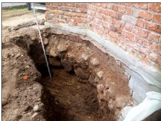
Ryc. 7. Mielżyn, gm. Witkowo – remont fundamentów kościoła p.w. Wszystkich Świętych. Nadzory archeologiczne 2024. Fundamenty pod południowy mur nawy i przyporę flankującą fasadę od strony południowej (fot. P. Wawrzyniak).
