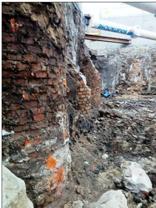
Ryc. 4. Poznań, ul. Garbary 68. Pozostałości tzw. szklanek fundamentowych pod mury kamienicy z przełomu XIX/XX wieku, zniszczonej wypadkami wojennymi w 1945 r., zlokalizowane wzdłuż wschodniego muru szczelinowego wykopu budowlanego (fot. P. Wawrzyniak).
