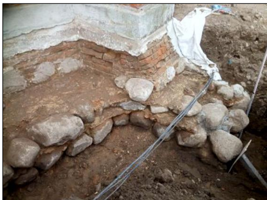
Ryc. 6. Mielżyn, gm. Witkowo – remont fundamentów kościoła p.w. Wszystkich Świętych. Fundamenty pod ścianę wschodnią prezbiterium oraz przyporę (fot. P. Wawrzyniak).
