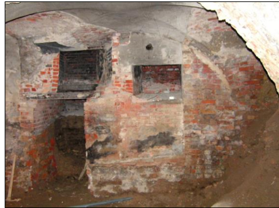
Ryc. 3. Kościół oo. franciszkanów w Poznaniu. Prace budowlane w kryptach – murowana ściana ossuarium nr 1 (fot. J. Wrześciński)
