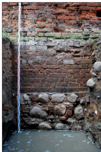
Ryc. 4. Gołańcz, gm. Gołańcz, pow. Wągrowiec, woj. wielkopolskie, stan. 1. Fundament muru obwodowego zamku odsłonięty w wykopie 1/2009
